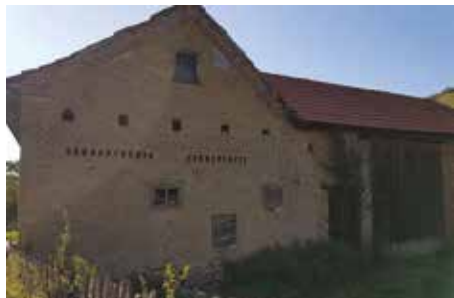
Casă din cărămidă nearsă
